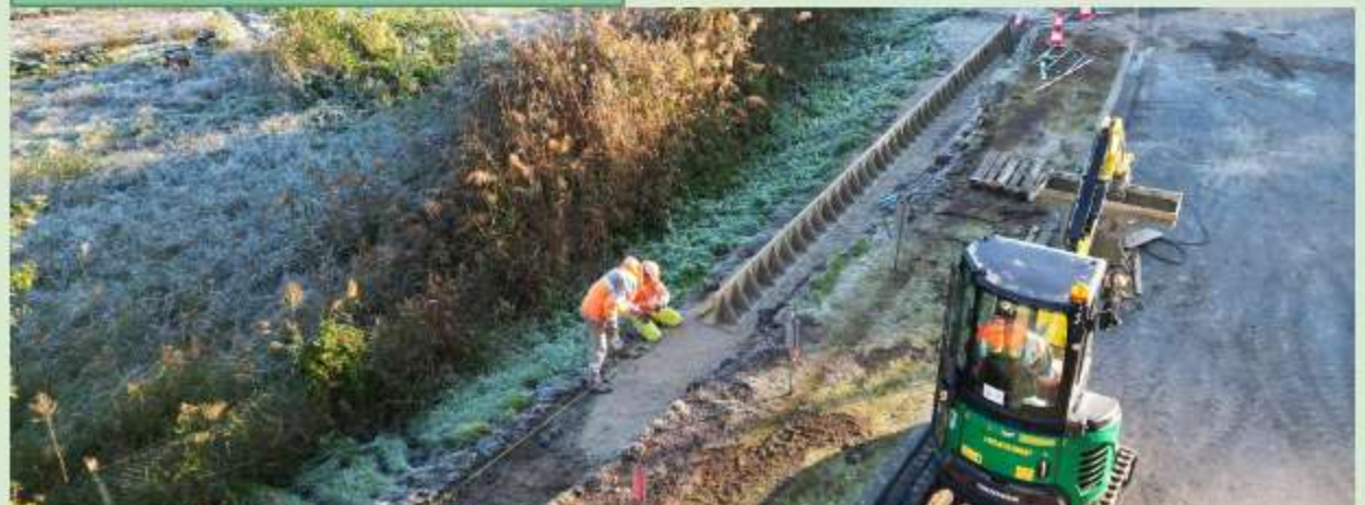
Travaux de construction du Crapauduc
