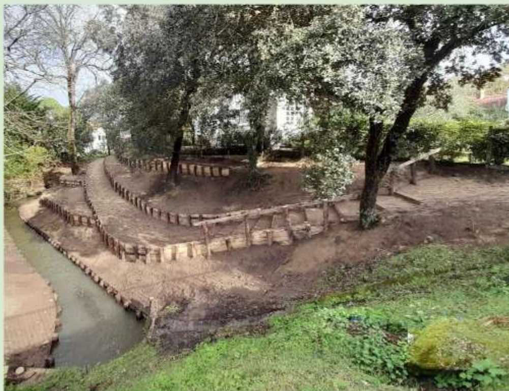
Le site après les travaux
