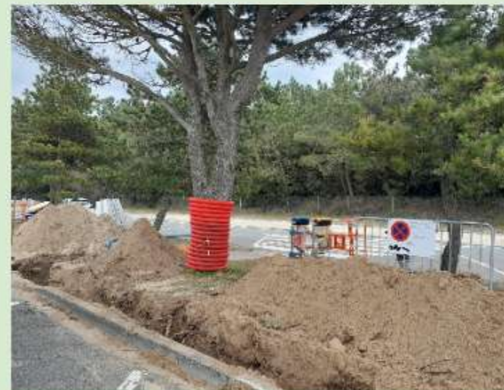
Protection des pieds d'arbre lors de la rénovation des luminaires du front de mer
