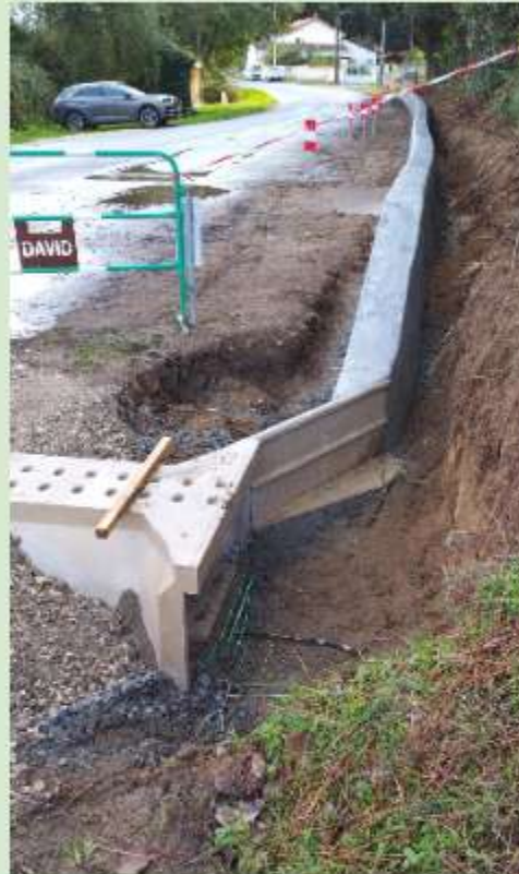
Travaux de construction du Crapauduc
