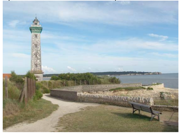
Le Phare de Saint-Georges, point de repère de la Pointe de Vallières.
