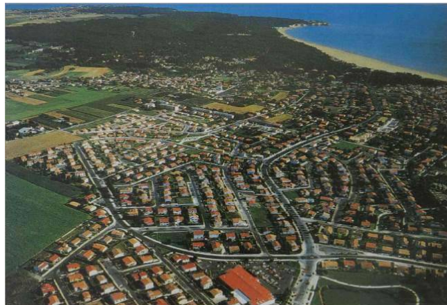
Le quartier "Plein Été", créé à partir de 1970 (Saint-Georges-de-Didonne : mémoires pour l'an 2000...).
