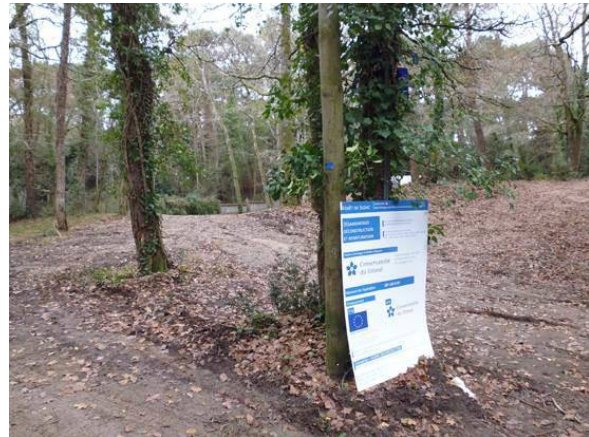
Des espaces naturels sensibles du littoral permettant au Conservatoire du Littoral d'acquérir le foncier et d'engager des opérations de démolition et de renaturation de la forêt
