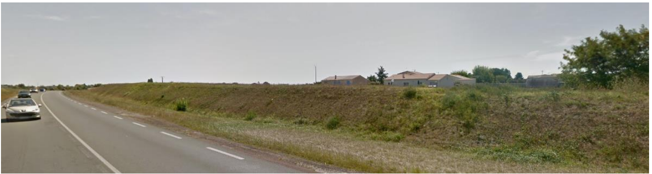
2 – Vue depuis la RD25 du prolongement du merlon existant au Nord du projet
